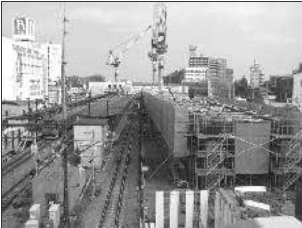
着々と進むJR中央本線連続立体交差事業
