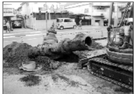
耐震性の強化と漏水防止を目的とした配水管の布設替工事
