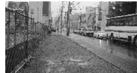
拡幅工事のすすむ小金井街道
