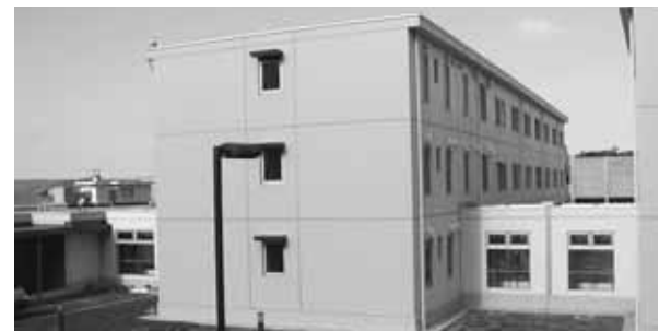
三宅村活動火山対策避難施設
