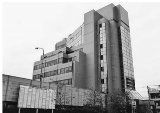
庁舎としての耐震性能を有していない第二庁舎
