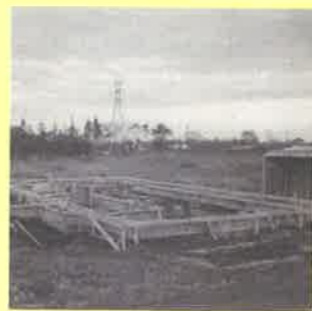
基礎工事中の自宅。奥の鉄塔付近は西武多摩川線。1959(昭和34)年11月22日撮影
