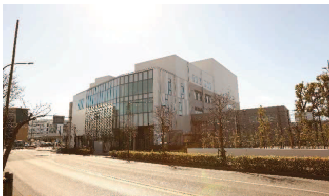
メタウォーターサステナブルパーク小金井 （小金井市資源物処理施設）
