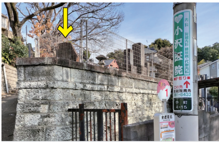
A. 金蔵院の坂から見える大久保善左衛門の墓。金蔵院の坂は戦後になって小金井街道の陸橋と接続した。
