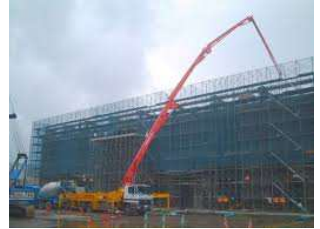
⑨地上躯体コンクリート打設
