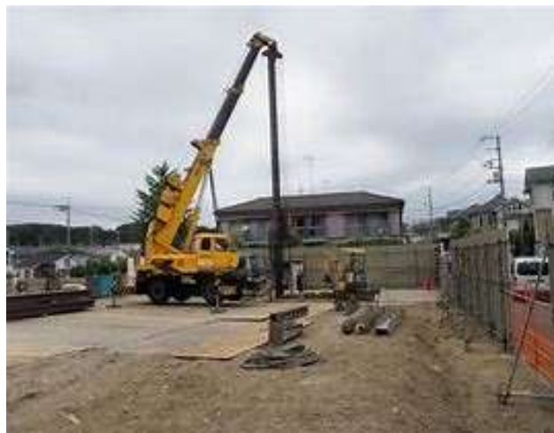
④山留工事
