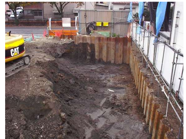
⑥土工事(掘削工事)
