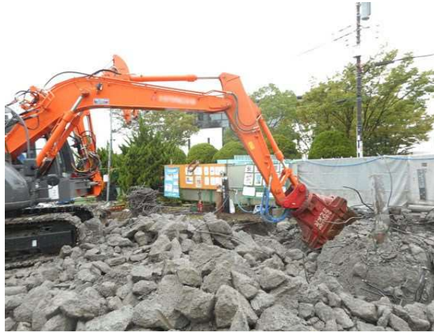
②貯水槽等解体工事
