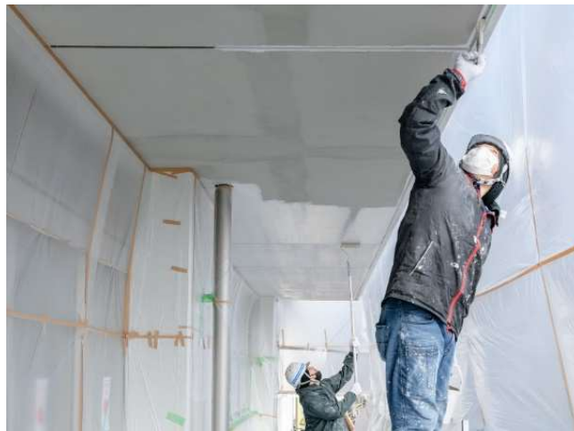
⑪外装工事
