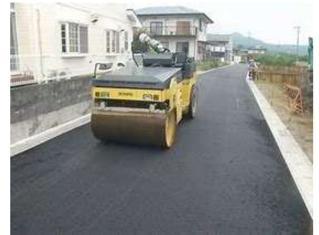
⑫外構工事
