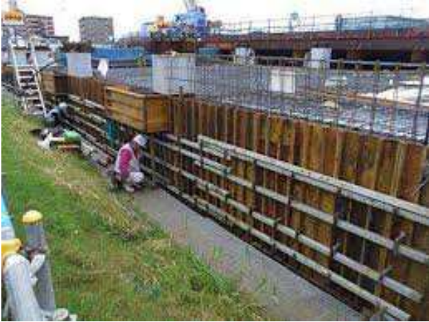
⑦基礎工事
