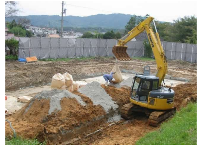
③地盤改良工事
