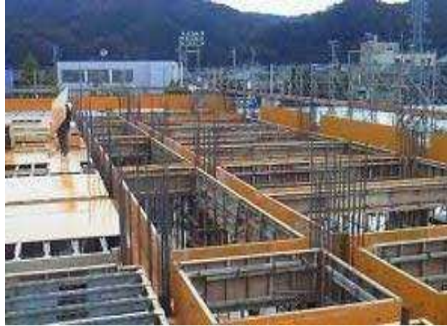
⑧地上躯体工事
