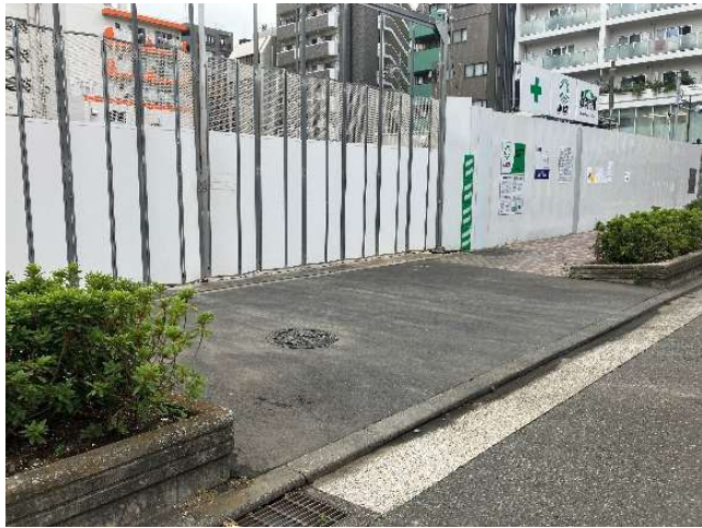
①準備作業・仮囲い
