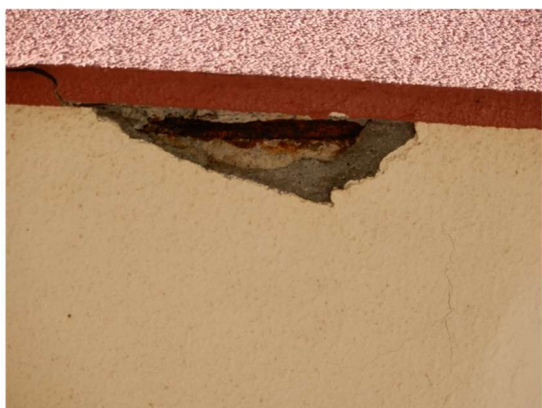
本町小 校舎2・体育館 (⑬-1・2棟) D評価 非常階段の近くの軒下に露筋。
