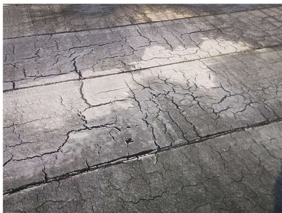
東小学校 校舎-3(⑫棟) C評価 露出防水が劣化している
