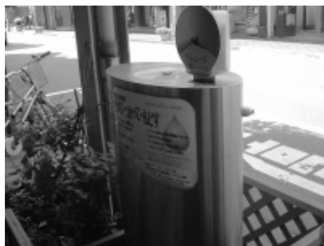
雨水貯留タンク
