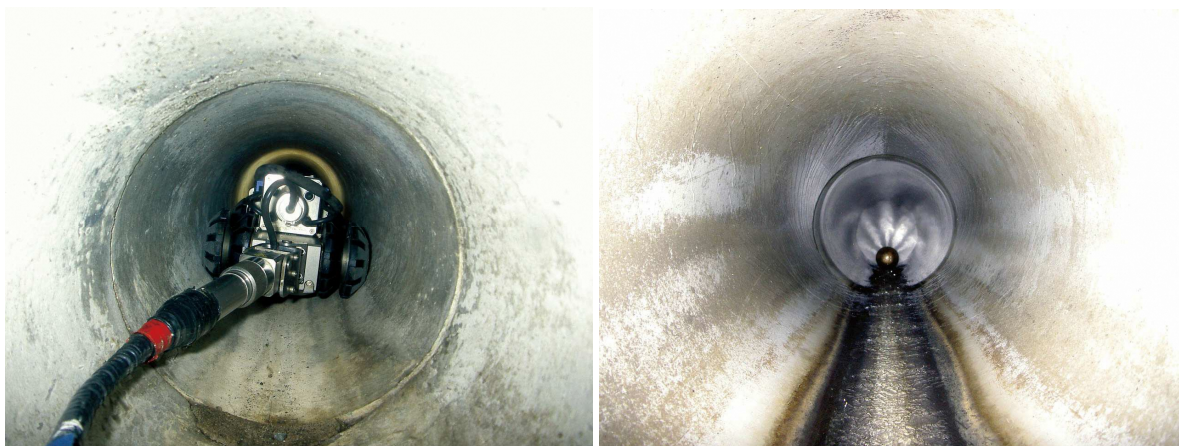
図 4-2 管路カメラ調査
