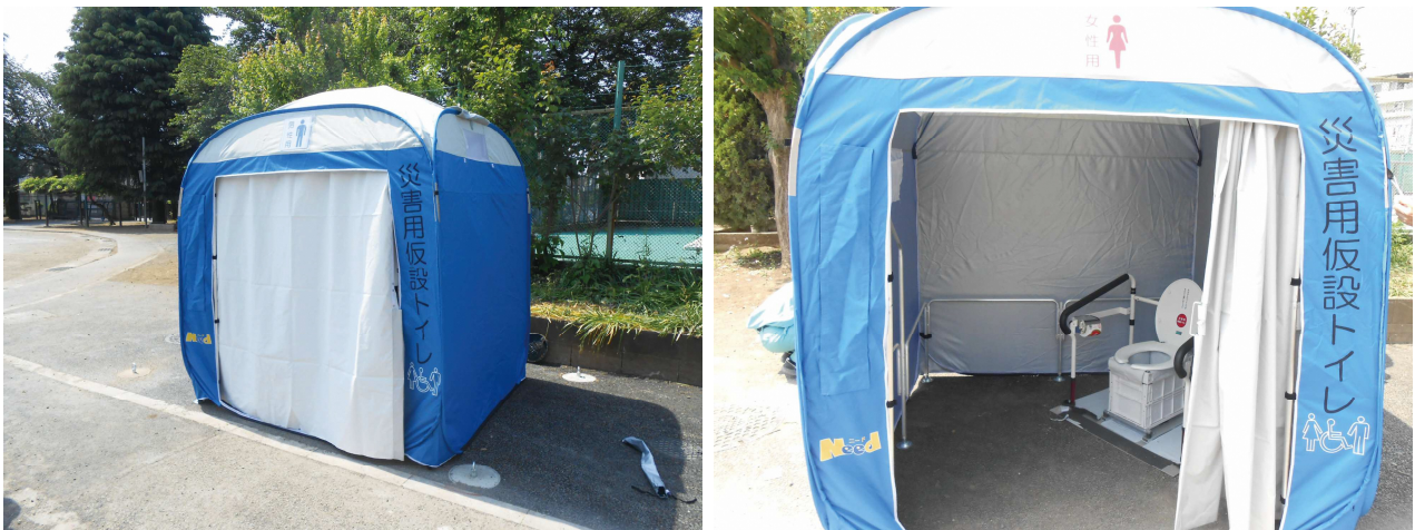
図 3-8 マンホールトイレ写真
