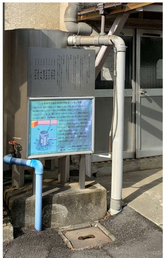
図 3-16 雨水貯留・浸透施設モデル
