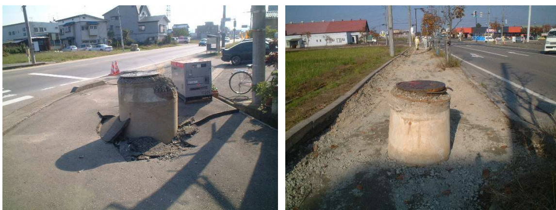
図 4-3 マンホール浮上状況
