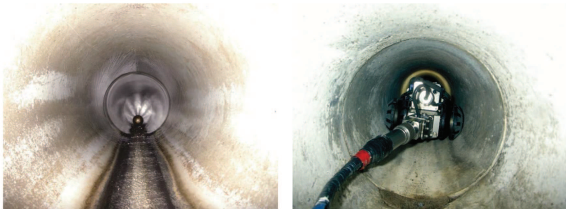
図 4.2 管路カメラ調査
