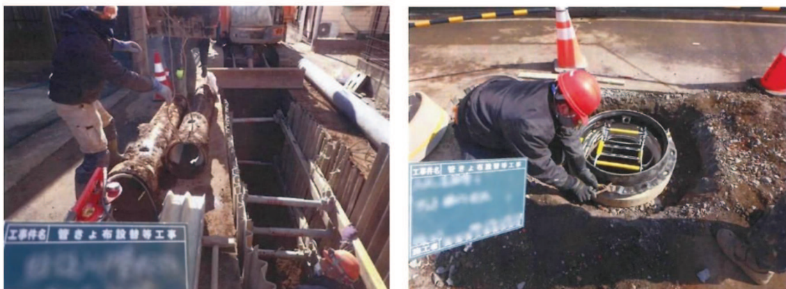
図 4.3 管路・マンホールの修繕・改築
