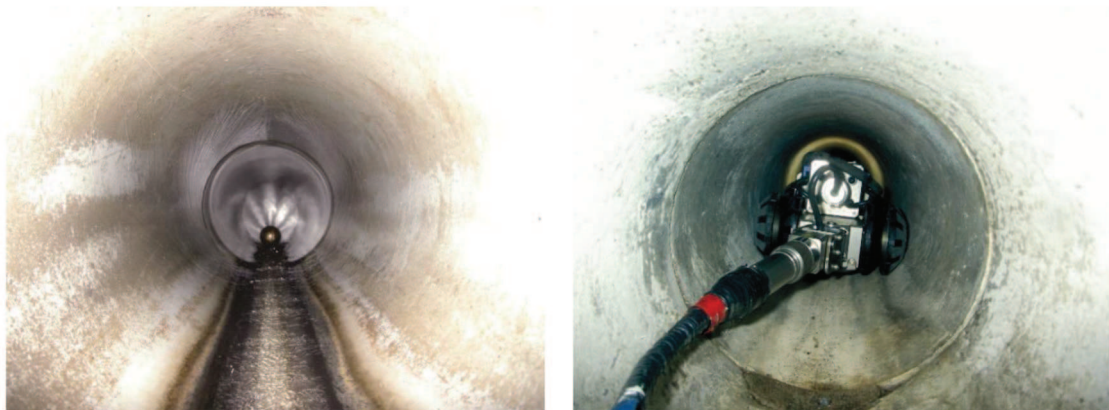
図 4.2 管路カメラ調査
