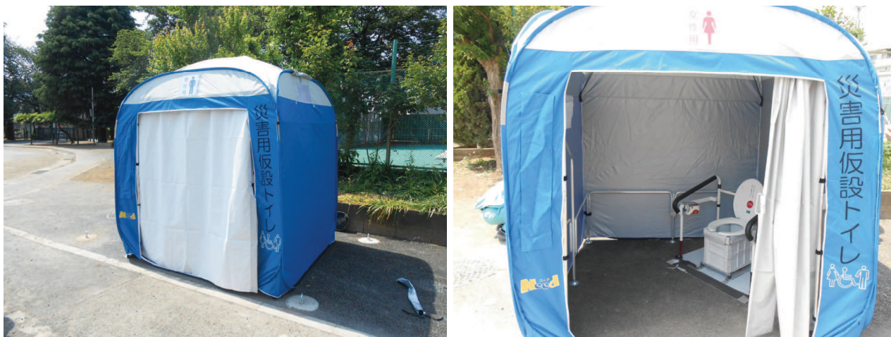
図 3.6 マンホールトイレ写真
