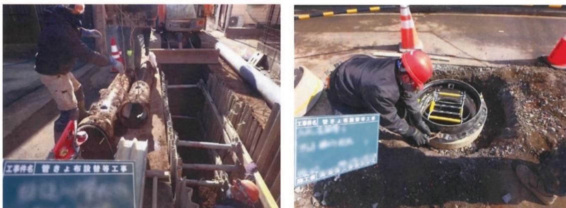
図 4.3 管路・マンホールの修繕・改築
