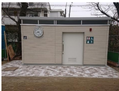
公園トイレの整備
