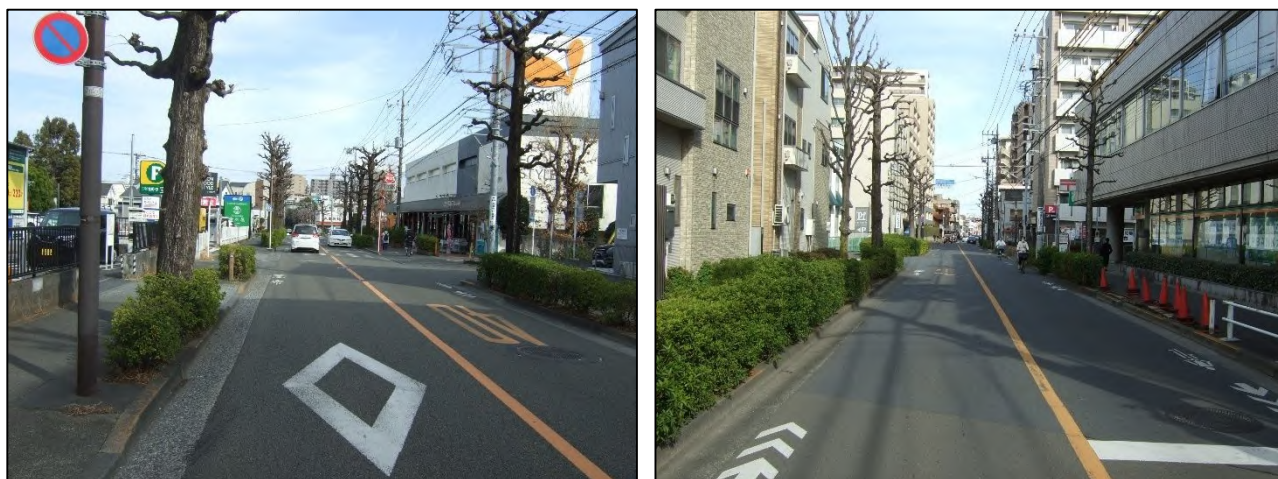
図 4.10 市道第1号線（北大通り）市道第345号線～小金井街道の状況
