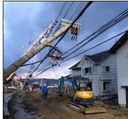
2024（令和6）年 能登半島地震（石川県輪島市）（出典：国土交通省資料） 図 電柱倒壊による被害事例
