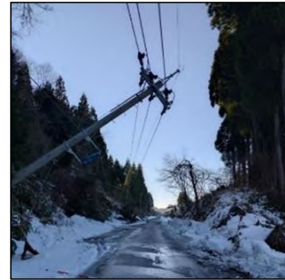
2024（令和6）年 能登半島地震（石川県輪島市）（出典：国土交通省資料） 図 電柱倒壊による被害事例
