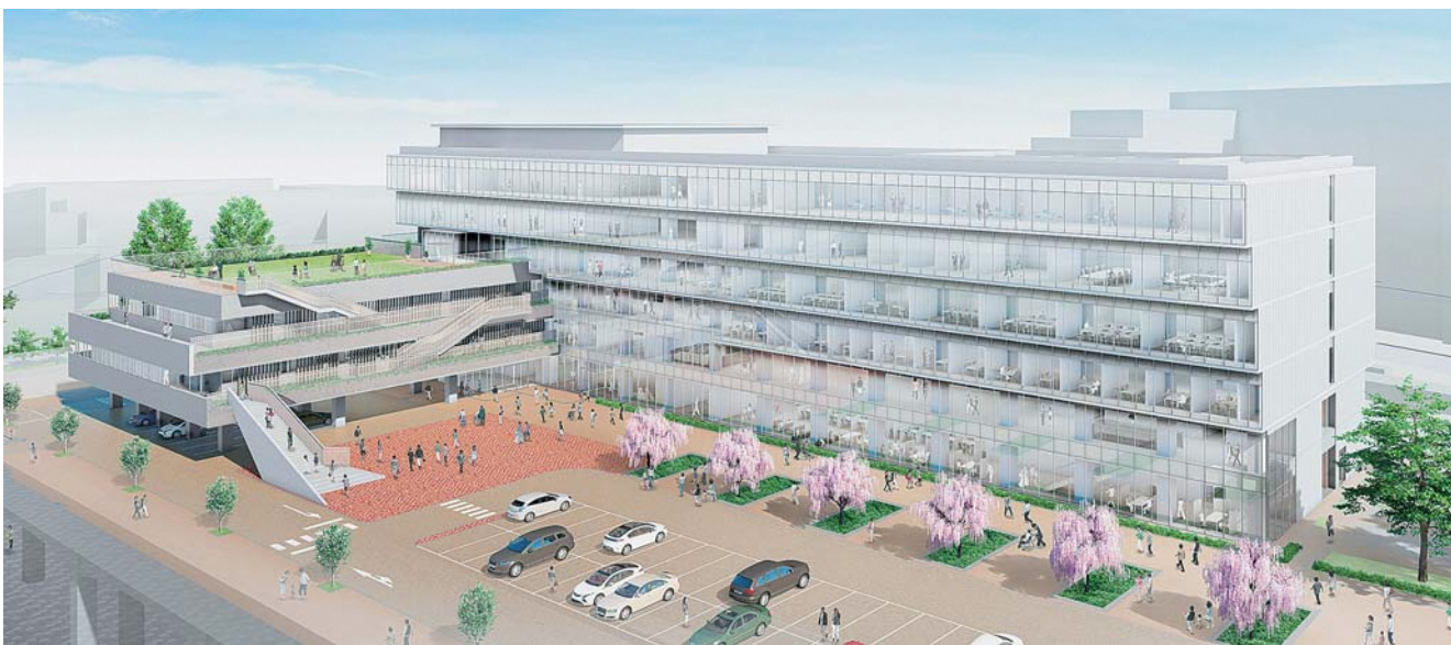
※庁舎屋上部分に都防災無線の鉄塔(約20m)を設置する予定です。
