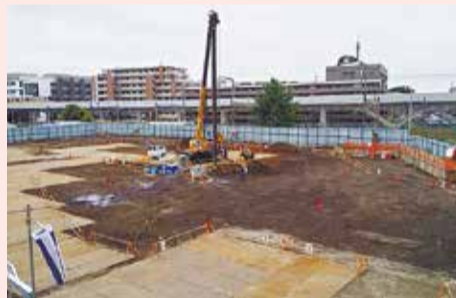
山留工事のようす
