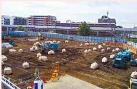
地盤改良作業のようす
