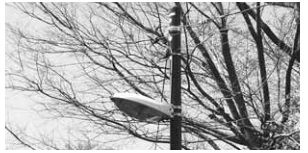
照度アップ! 32Wの明るい街路灯
