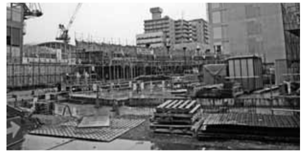
(仮称)市民交流センターの工事現場
