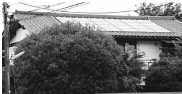
市内の住宅の屋根に設置された太陽光パネル
