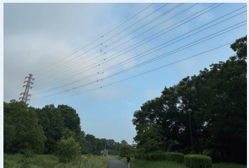
都市計画道路小金井3・4・11号線予定地上空の送電線
