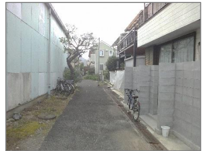
③ 敷地内通路
