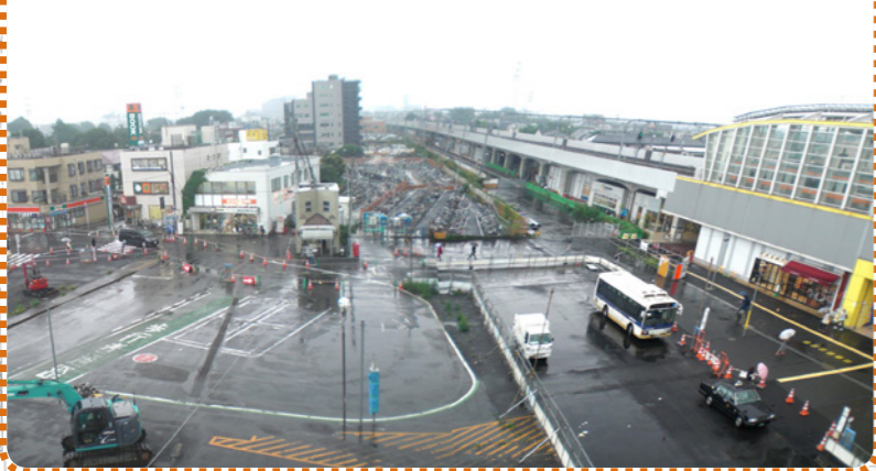
駅前交通広場整備状況 (平成 27 年 7 月撮影)
