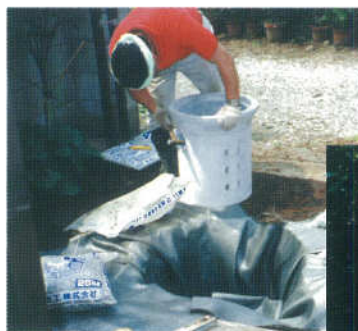
雨水浸透樹設置のようす
