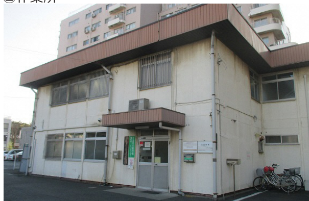
③多目的作業所 (2階一部)
