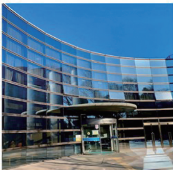
小金井市総合体育館
