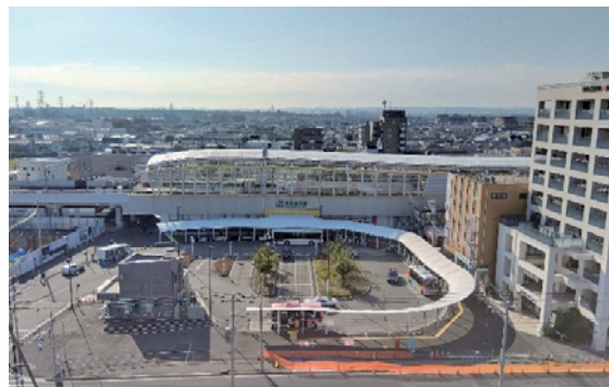
東小金井駅北口交通広場
