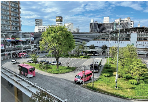
武蔵小金井駅南口駅前ロータリー
