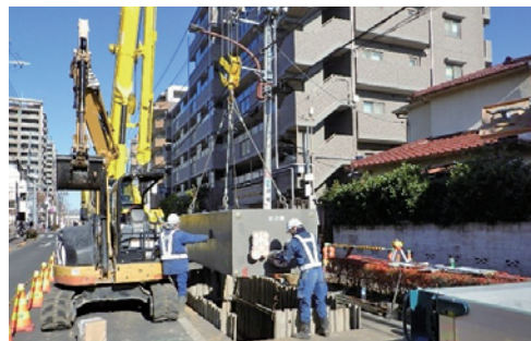
無電柱化工事
