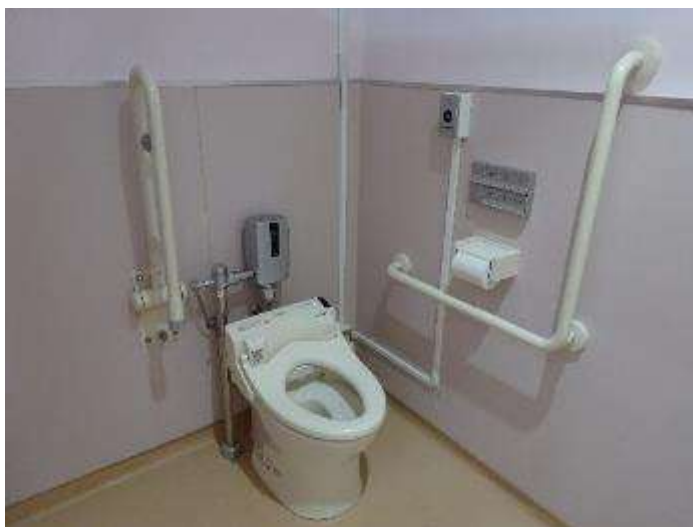
小学校トイレ改修工事
