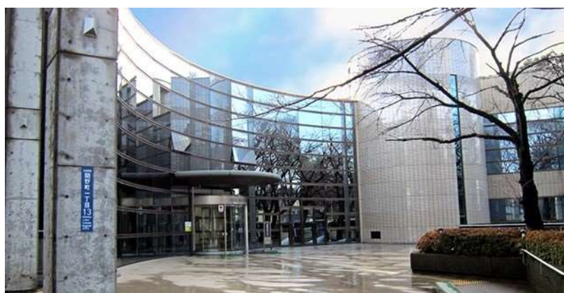
小金井市総合体育館
