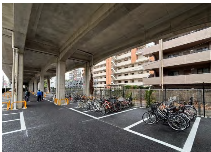
新保管所（ＪＲ中央線高架下保管所）の様子
