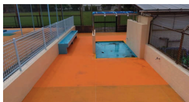
小金井第二小学校プールシャワー壁等改修工事
