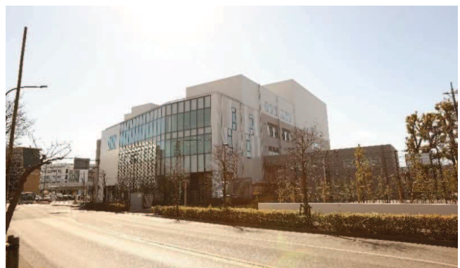
メタウォーターサステナブルパーク小金井 (小金井市資源物処理施設)
