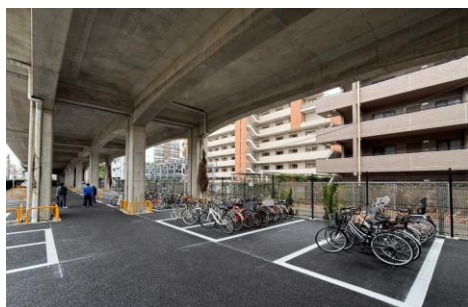
新保管所（J R 中央線高架下保管所）
